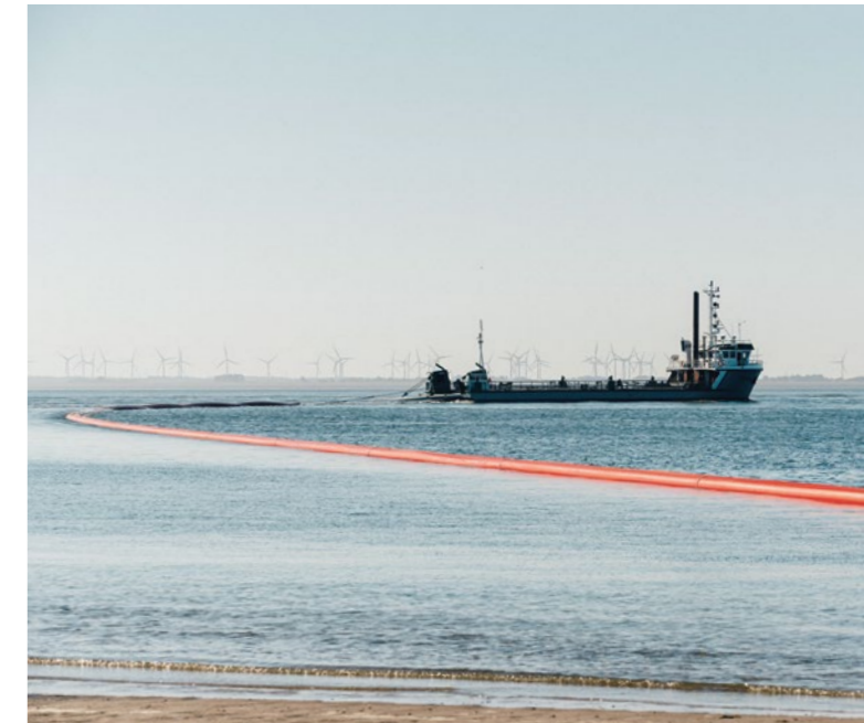
Einschwimmen der Kabelschutzrohre auf Norderney
