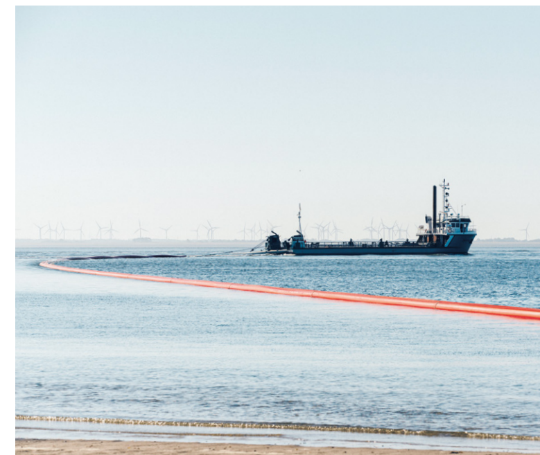
Einschwimmen der Kabelschutzrohre auf Norderney
